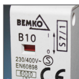
kontrolka sygnalizująca zadziałanie
